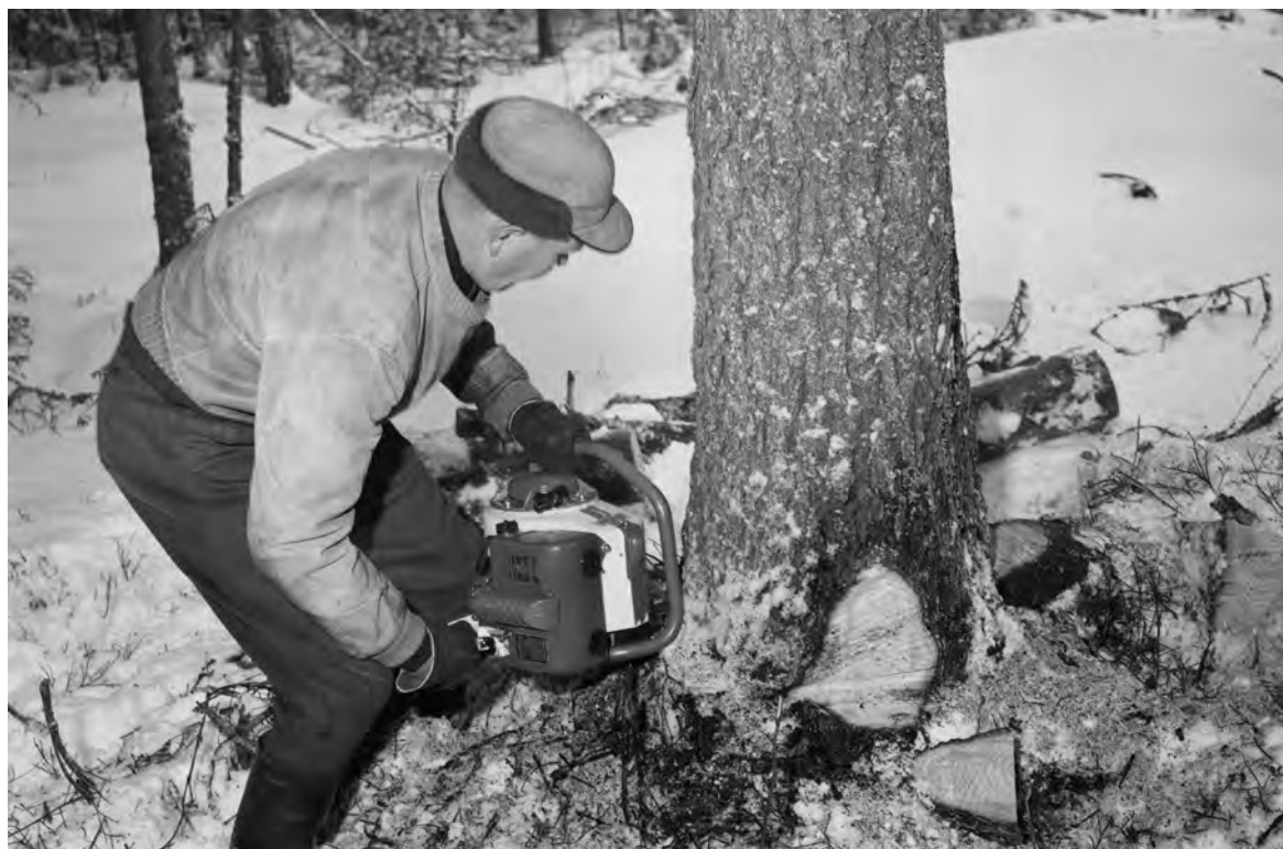
Puuta kaadetaan Hyry 10-moottorisahalla 1950-luvulla. Kuva: M. Mannelin, Lusto, Metsätehon kokoelma.
